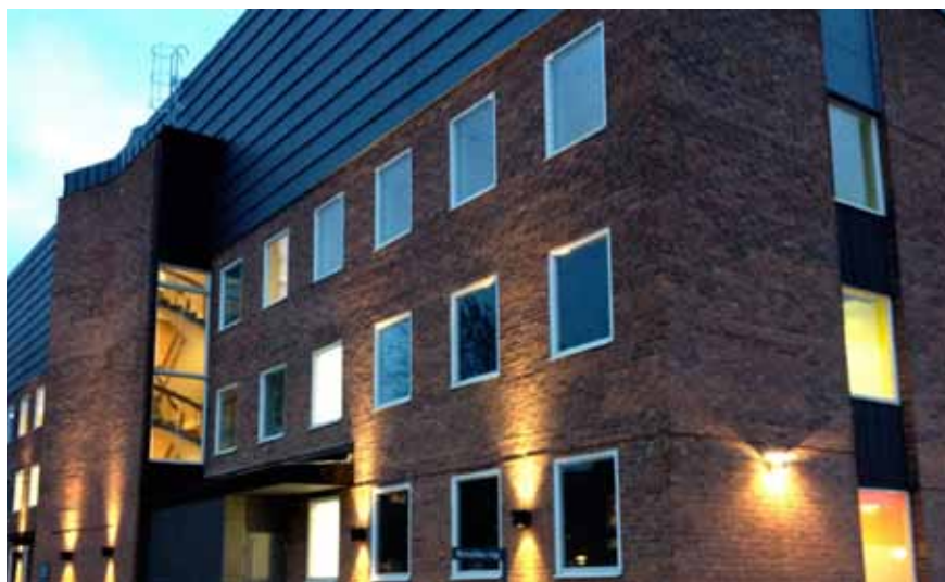
Ombyggnationerna av laboratorielokalerna på Wallenberg-labb är nu färdiga.
