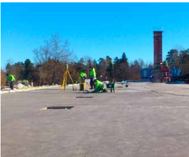
Arbetet med uppbyggnaden av Sigtunahöjden är nu i full gång.
